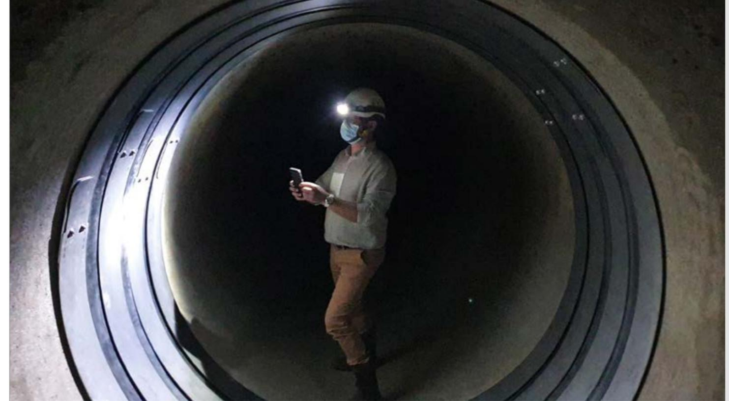
Réparation par l'intérieur d'une conduite de refoulement qui alimente le canal des Costières © BRLE
