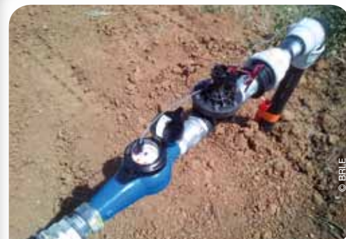
Compteur et électrovanne télégérés
