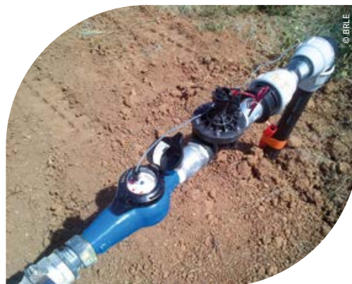
Compteur et électrovanne télégérés
