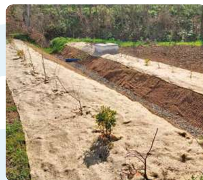
Mesure compensatoire de restauration de haies © BRL
