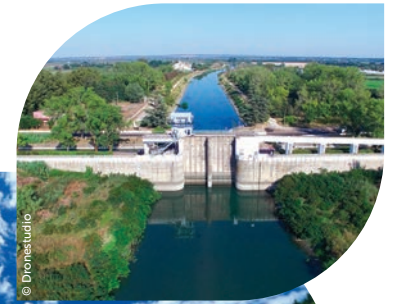
Ouvrage de prise au Rhône
