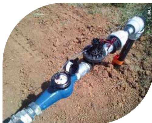
Compteur et électrovanne télégérés
