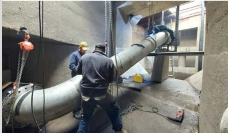
Pose de vannes connectées par les équipes exploitation de BRL © BRLE
