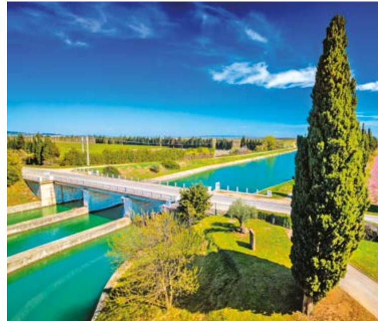
106 km de canaux entre le Rhône, Nîmes et Montpellier pour irriguer les plaines et alimenter le littoral, les agglomérations et les milieux naturels © G&C Deschamps
