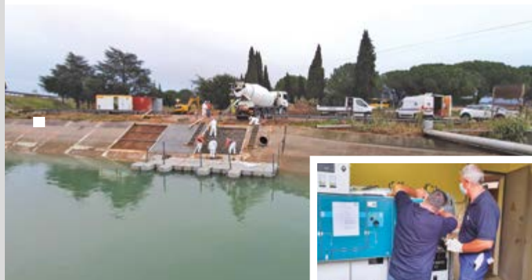
Nettoyage et remise en service d'une station de pompage inondée et réparation du canal P. Lamour suite aux inondations © BRLE
