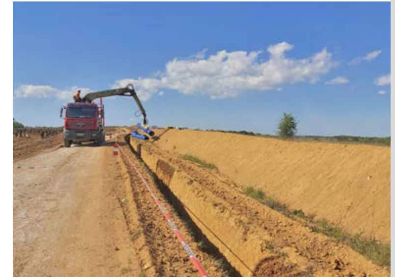
Chantier du Périmètre Nord Est Béziers © Marine Fava/BRLI
