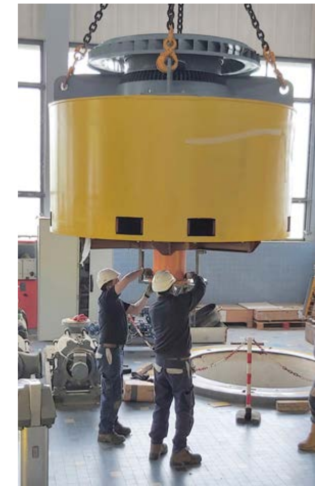
Reconstruction du stator d'un des moteurs de la station Aristide-Dumont © BRLE
