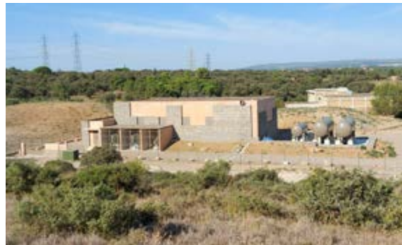
Fin du chantier de la station de Fabrègues © Maurice Quien / BRLI
