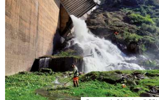
Barrage de Sénéchas © BRL
