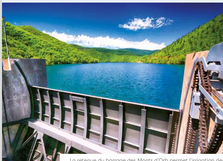
La retenue du barrage des Monts d'Orb permet l'irrigation des plaines biterroises, l'alimentation en eau potable du littoral audois et héraultais, le soutien d'étiage du fleuve Orb et la production d'hydroélectricité. © G&C Deschamps
