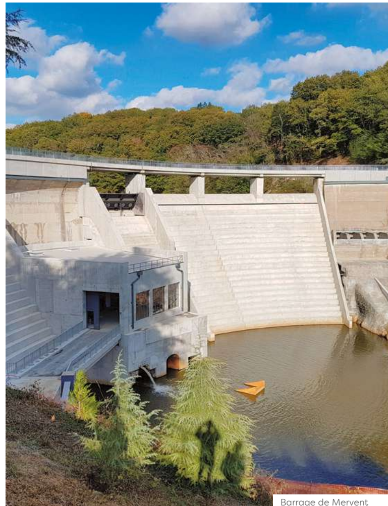
Barrage de Mervent (85 - Vendée) © BRLI
