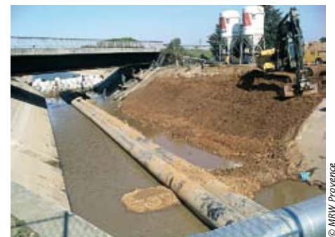
Réparation du canal Philippe Lamour près de Vauvert, Gard
