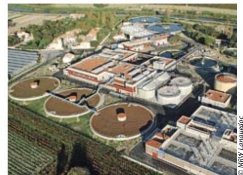
Conduite d'opération (avec la SERM) de la station d'épuration Maera
