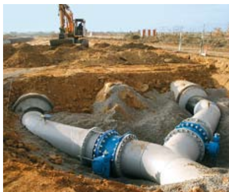
Maîtrise d'ouvrage du déplacement de réseaux d'eau brute - Aéroport de Béziers-Vias
