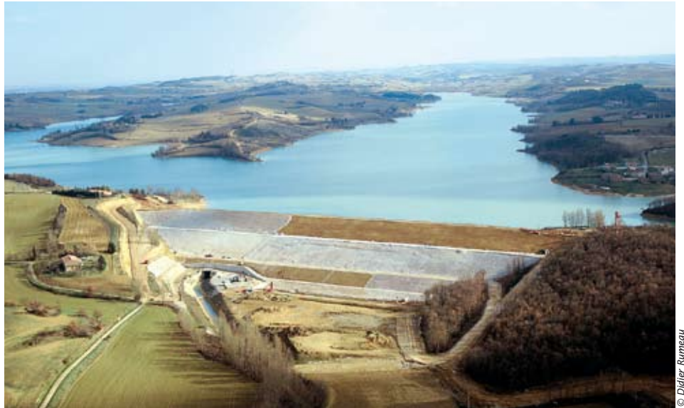
Travaux de surélévation du barrage de la Ganguise dans le Lauragais audois
