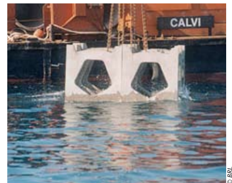
Installation de récifs artificiels dans la baie d'Aigues Mortes
