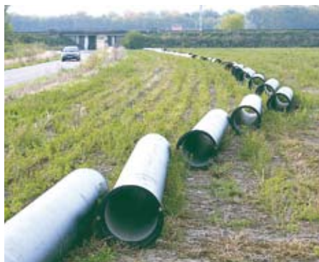
Création du périmètre irrigué d'Alzonne
