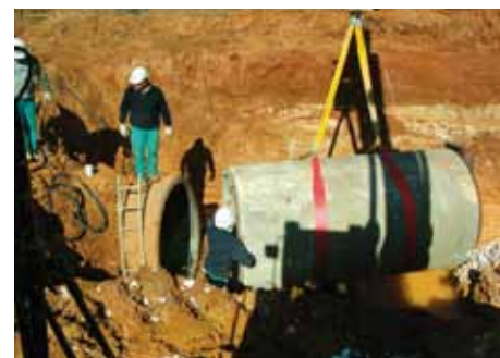
Travaux sur le réseau de distribution BRL
