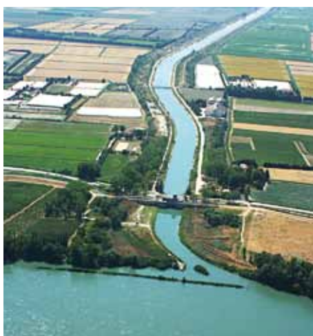
Transfert des eaux du Rhône via les canaux créés par BRL
