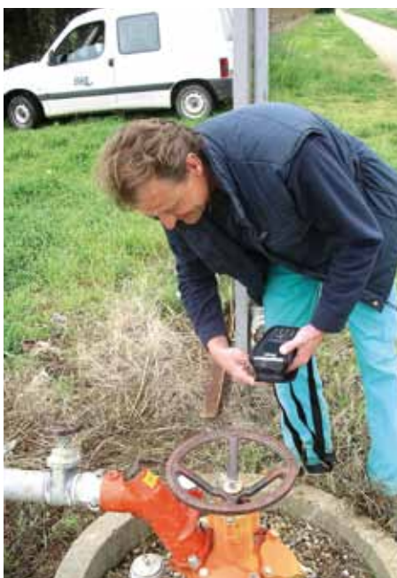
Compteur sur une borne d'irrigation BRL
