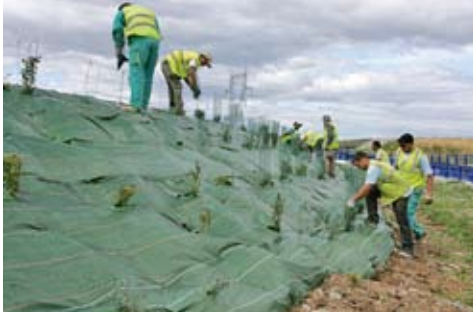
Chantier du LIEN (St Mathieu de Trévières-34)
